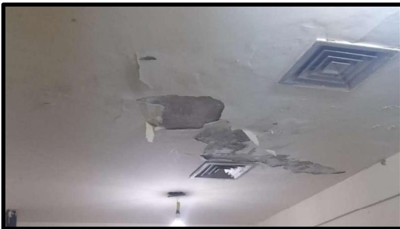
*Infiltração no Teto, sob laje em concreto, manta impermeabilizada e telhas onduladas em fibrocimento*
