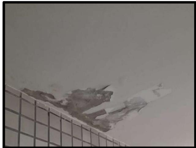
*Infiltração no Teto, sob laje em concreto, manta impermeabilizada e telhas onduladas em fibrocimento*
