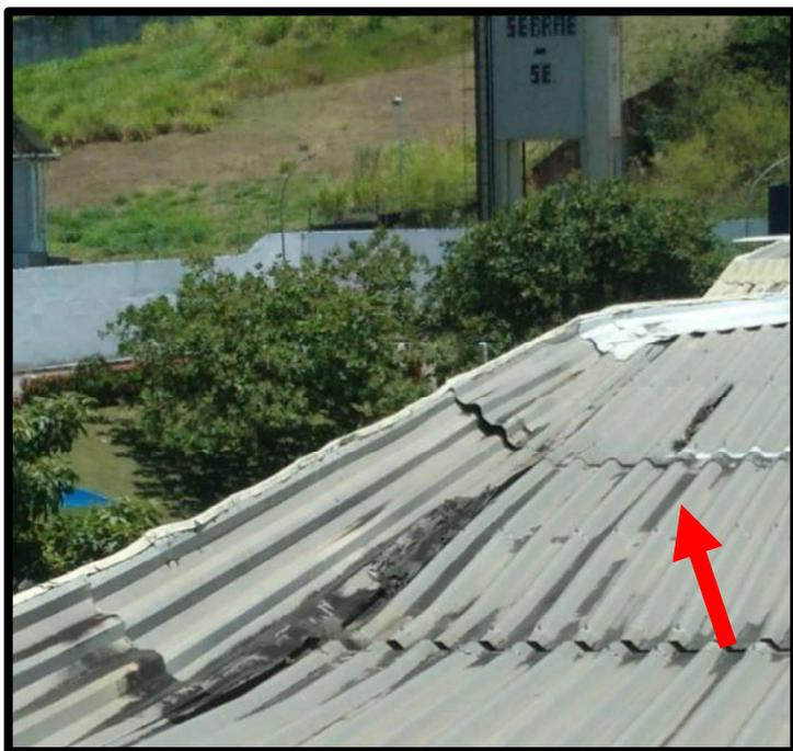
*Telhas em alumínio e manta asfálticas danificadas*
