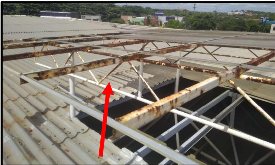
*Estrutura da Claraboia deteriorada*
