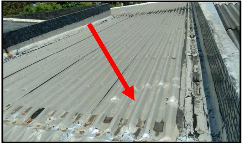
*Calhas em concreto, mantas asfálticas e telhas em alumínio danificadas*
