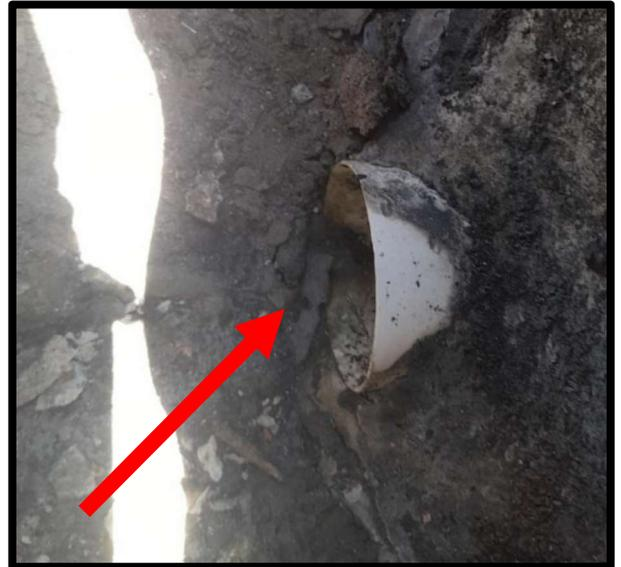
*Calha em concreto. Tubo de queda danificado e estrangulado*
